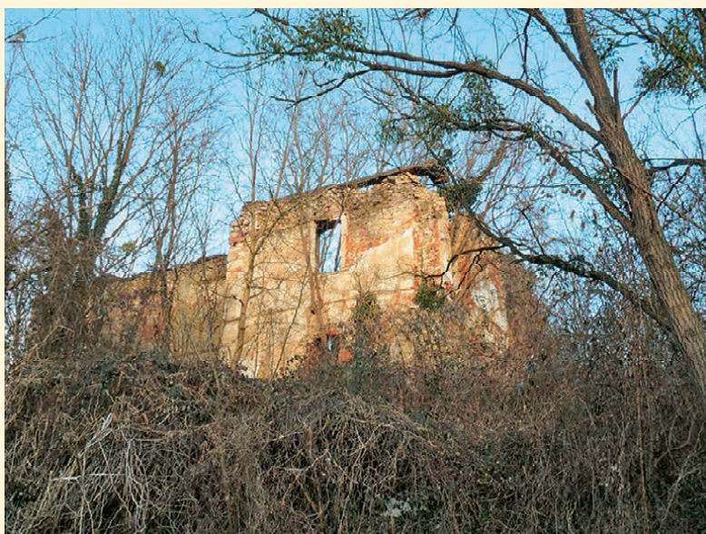
Slika 6. Cesargradski (Klanječki) Novi Dvori – detalj zapadnog pročelja dvorca, proljeće 2017. godine
